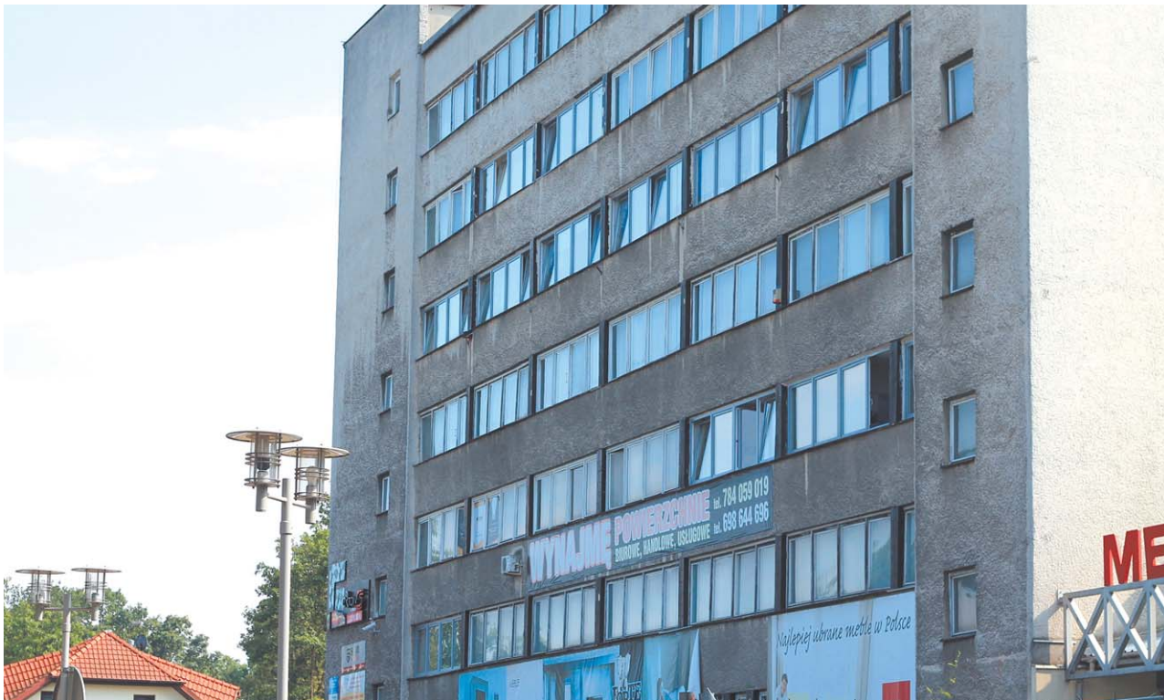
Cały biurowiec przy zbiegu ulic Słowackiego i Partyzantów, w tym pomieszczenia escape roomu „Open the lock”, jest ogrzewany z miejskiej sieci ciepłowniczej
