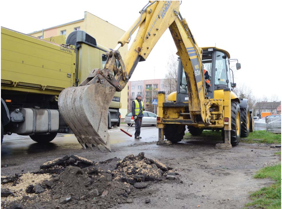
Prace przy modernizacji parkingu potrwają do jesieni
