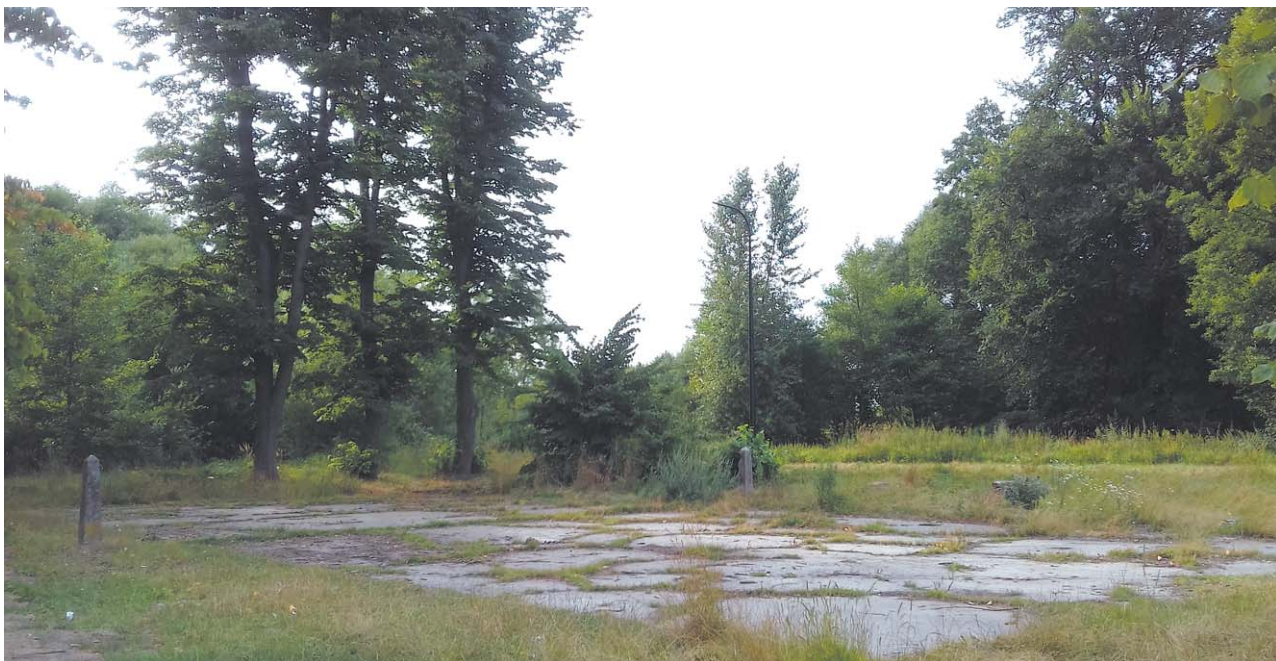
Tereny dawnych kortów. Od dziś to plac budowy
