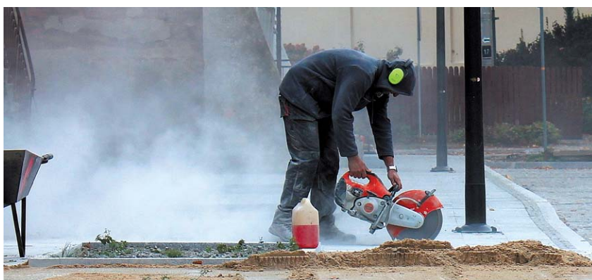
Na puławskim rynku pracy nie brakuje ofert, zwłaszcza w branży remontowo-budowlanej. Poszukiwani są m.in. brukarze, zbrojarze i operatorzy koparek
