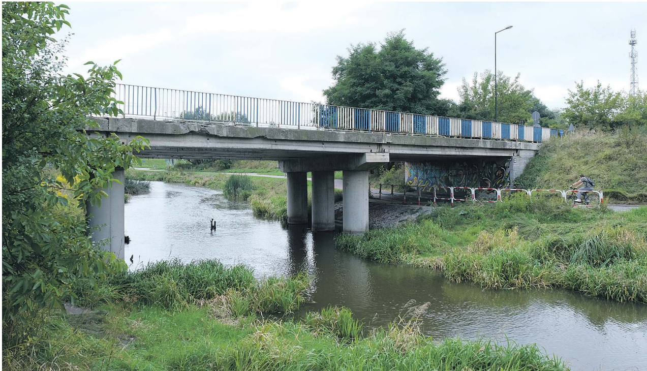
W warunkach przetargu określono, że wymiana mostu i przebudowa odcinka ul. Żeglarskiej ma trwać nie dłużej niż siedem miesięcy
