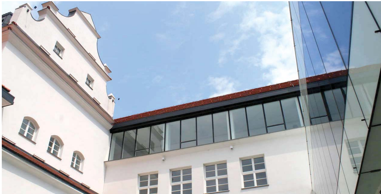
Żłobek, w którym przewidziano 25 miejsc dla dzieci do 3 lat, powstaje w budynku szkoły, w prawym skrzydle na parterze
