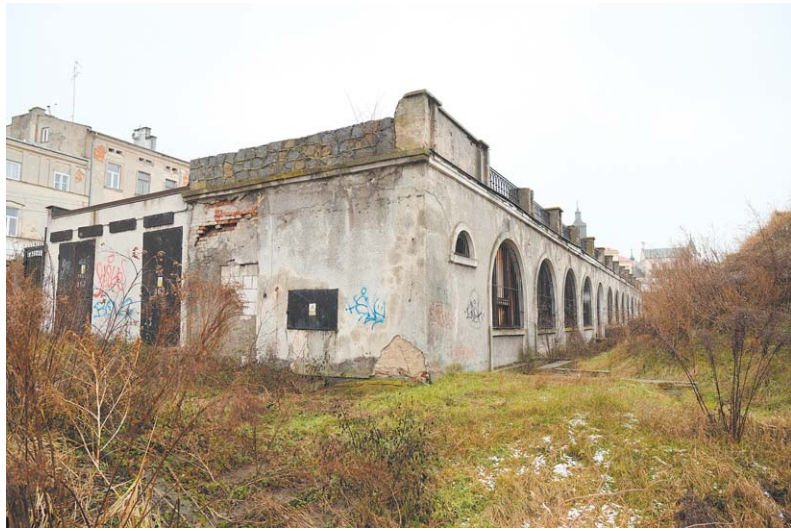
W czwartek komisja z Ratusza potwierdziła to, co od wielu lat widać gołym okiem – że budowa przy ul. Świętoduskiej nie ruszyła
