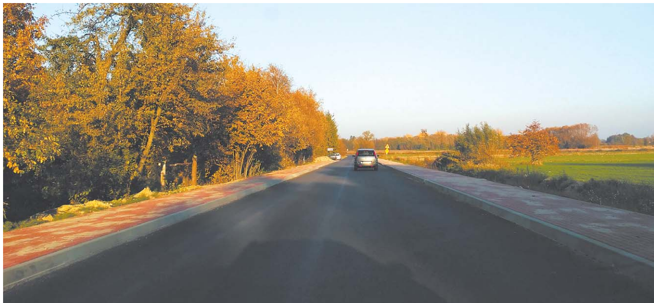
Tak jesienią wyglądał remontowany odcinek drogi Nadrybie–Urszulin
