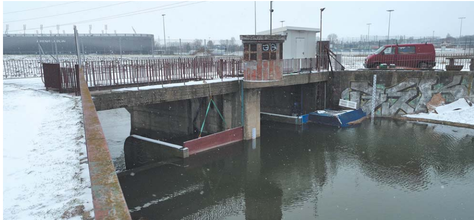
Poziom Bystrzycy przed elektrownią rzeczywiście jest wysoki, na co zwraca uwagę nasz czytelnik
