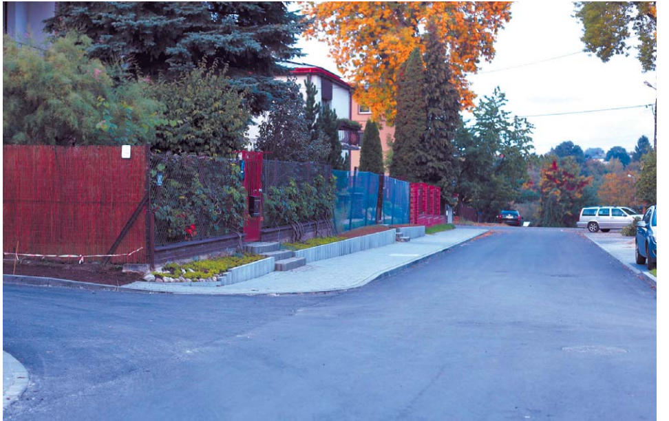
110-metrowa droga w ciągu ul. Oczki
