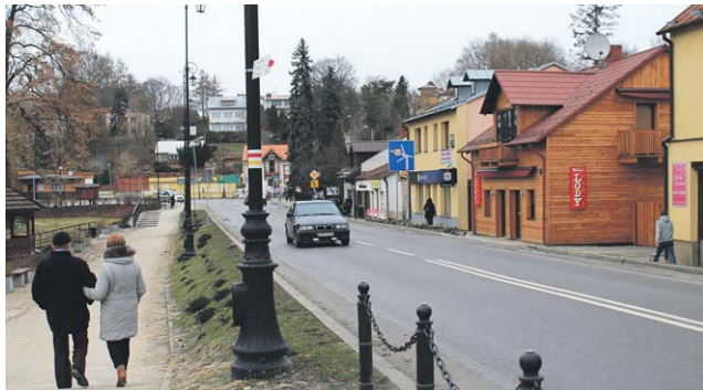
Ulica 1 Maja (na zdj.) wraz z al. Lipową i ul. Bochothnica do niedawna tworzyły kilkukilometrowy fragment drogi wojewódzkiej nr 830. Po zmianach cały ten odcinek trafił w ręce miasta Nałęczów
