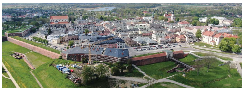
Stare Miasto w Zamościu i remont Nadszańca
