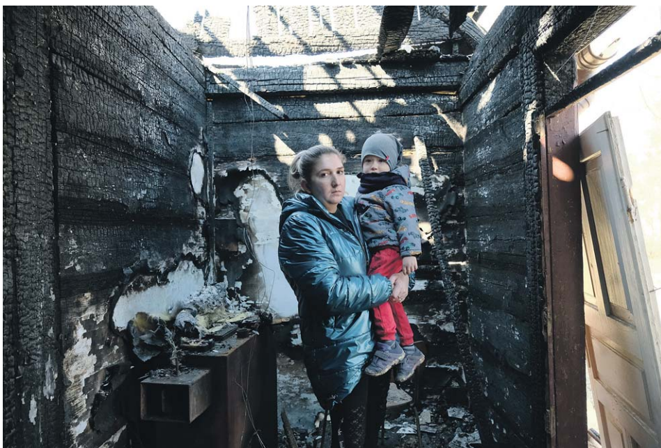
Pani Jolanta z 3-letnim synkiem Konradem w zniszczonym w wyniku pożaru domu
