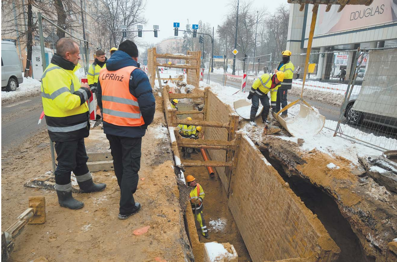
Drogowcy przebudowujący Lipową rozkopali środek jezdni przed Plazą. Mają tutaj układać nowy odcinek kanału burzowego
