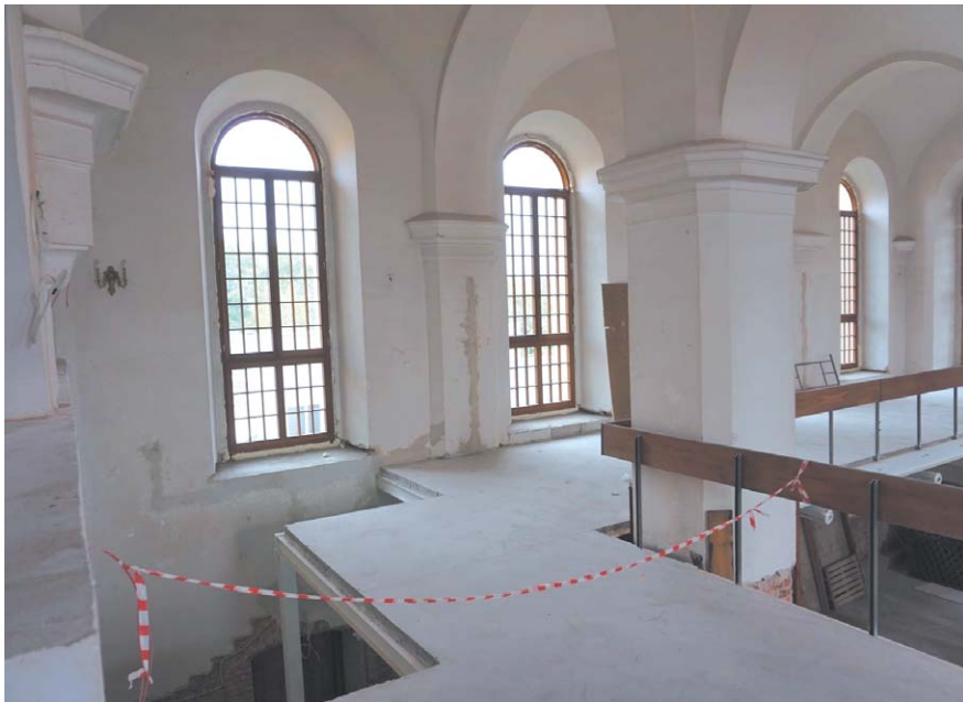
W bibliotece obecnie trwają prace wykończeniowe oraz przy wyposażaniu wnętrza
