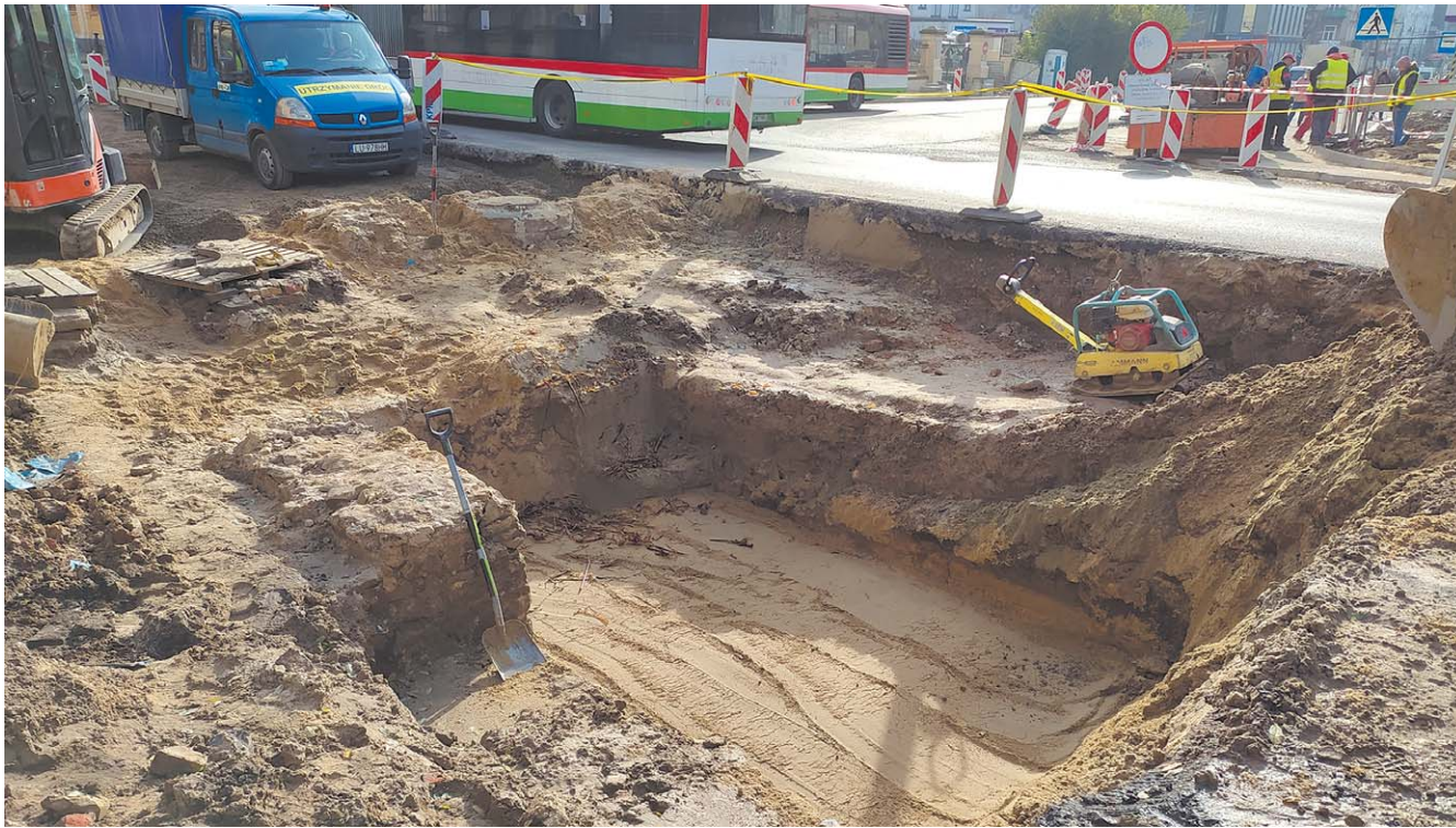
Wczoraj rano w wykopie okalającym stary mur robotnicy zagęszczali już świeżo wysypany piach
