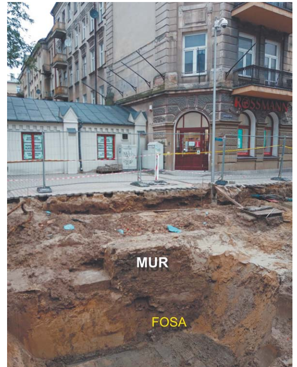
W system obrony miasta włączone były również odcinki suchej fosy
