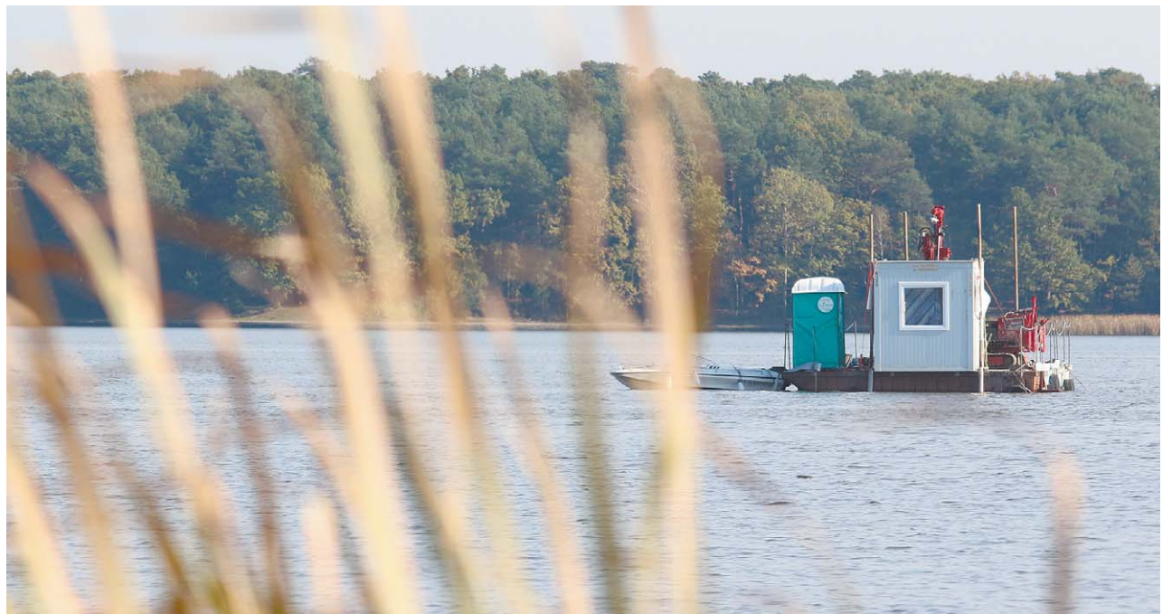
Na zalewie rozpoczęły się odwierty wykonywane urządzeniem na pływającej platformie
