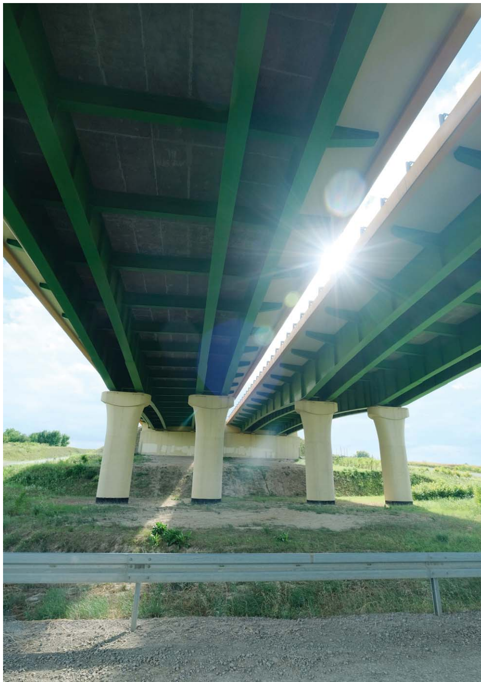
Do tragicznego wydarzenia doszło nocą z poniedziałku na wtorek (22 na 23 lipca) około godziny 1:20 na wiadukcie obwodnicy w Natalinie
