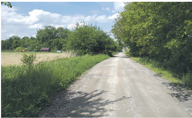
Góry Kluczkowickie. Miejsce od którego się zacznie nowa nawierzchnia drogi na którą czekają mieszkańcy
