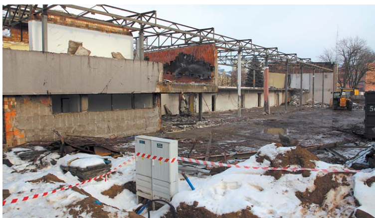
Rozbiórka pawilonu wystawowego przy ul. Wojska Polskiego
