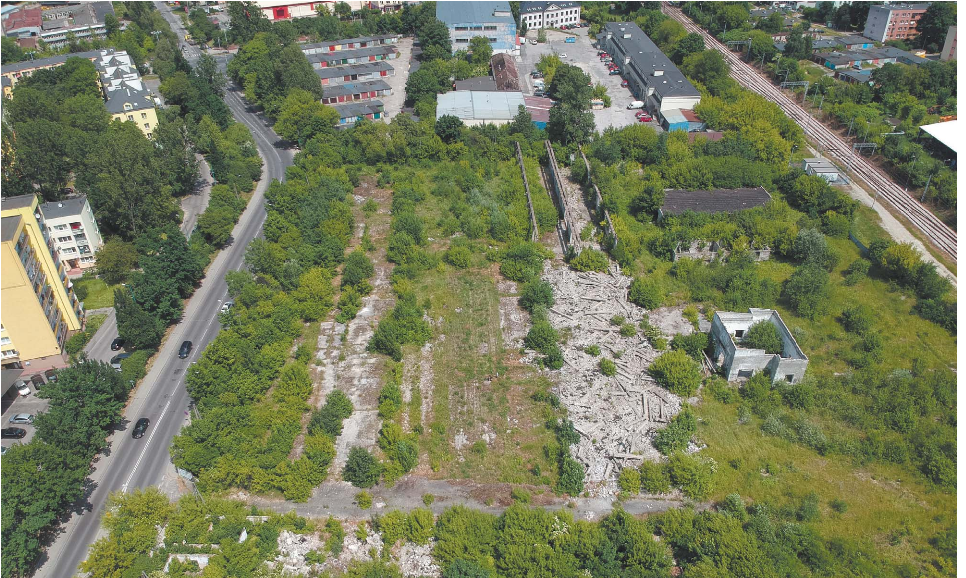
Investor chce zbudować osiedle na terenie po wytwórni prefabrykatów betonowych
