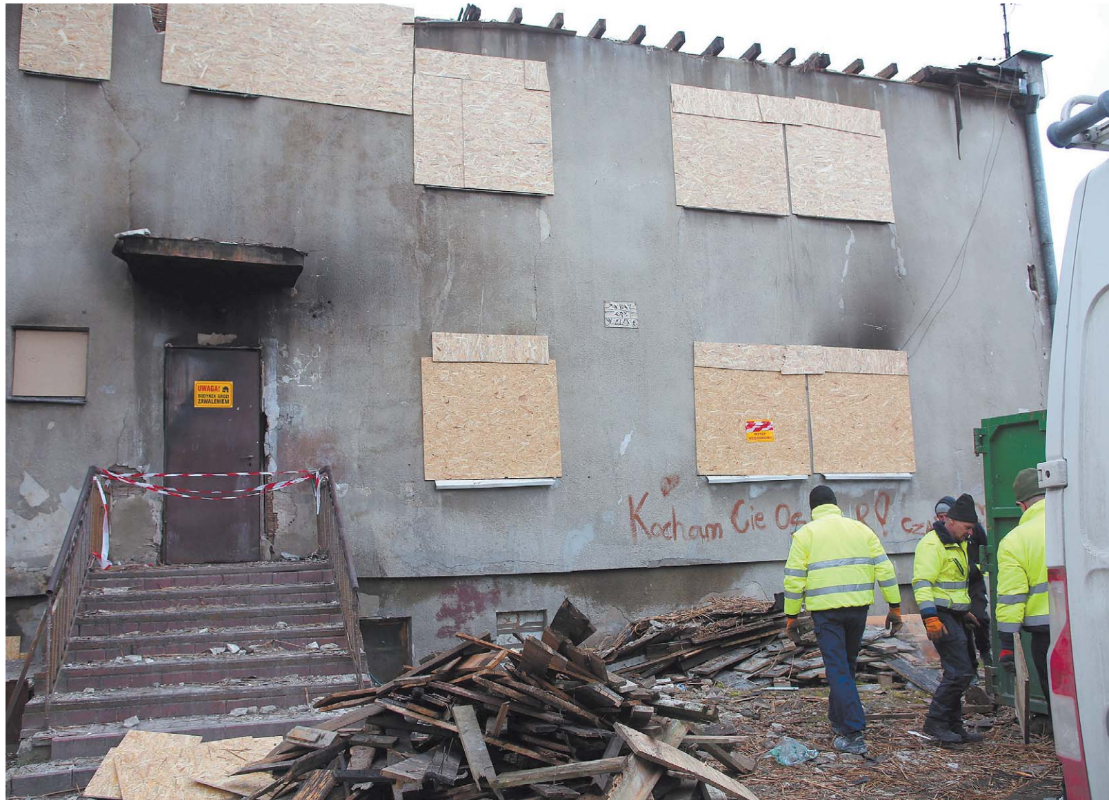
Wczoraj przy Wrońskiej zaczęły się kolejne prace zabezpieczające obiekt, by nie stwarzał on zagrożenia dla osób postronnych
