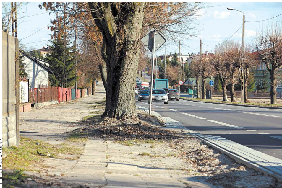
Chodnik przy Urzędowskiej jest w fatalnym stanie
