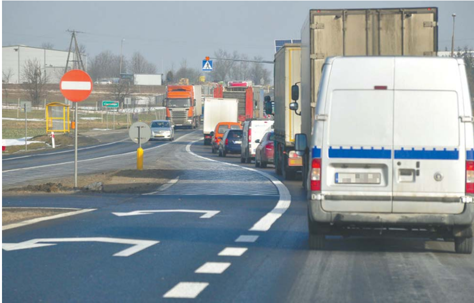
Odcinek S19 pomiędzy Lublinem a Lubartowem będzie częścią Via Carpatia
