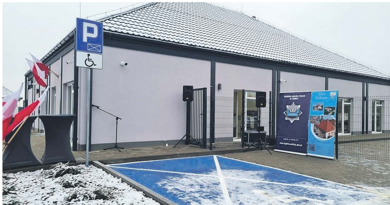
Koszt budowy modułowego posterunku, jaki w zeszłym roku oddano w dolnośląskich Prochowicach, to ok. 3,5 mln zł. Podobny może powstać w Żyrzynie
