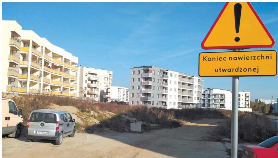
W przyszłym roku budowany ma być 500-metrowy odcinek ul. Berylowej od Onyksowej do Jantarowej
