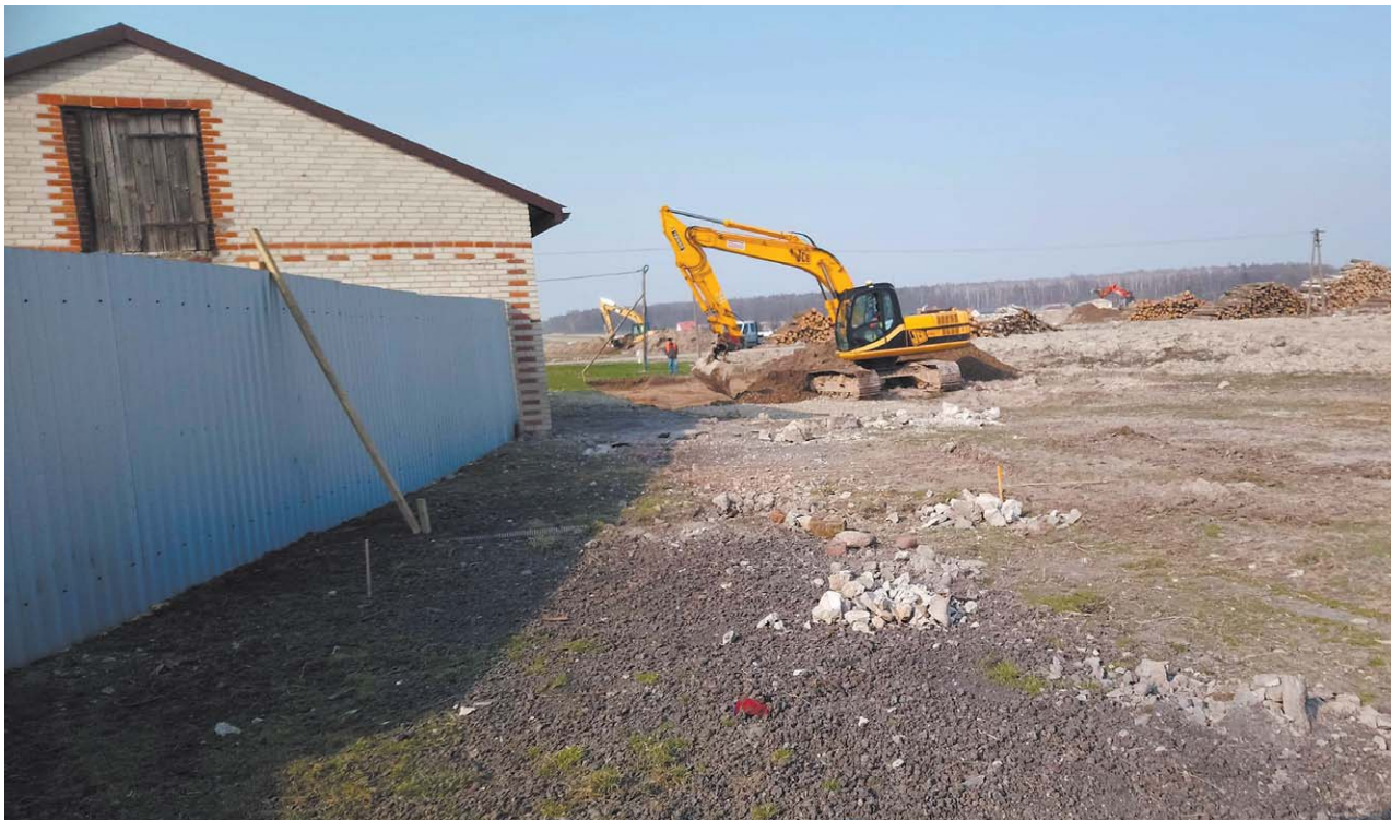
Zdjęcia nadesłane do naszej redakcji przez Henryka Bogutę pokazują, w jakiej odległości od jego zabudowań toczą się prace przy budowie drogi S19
