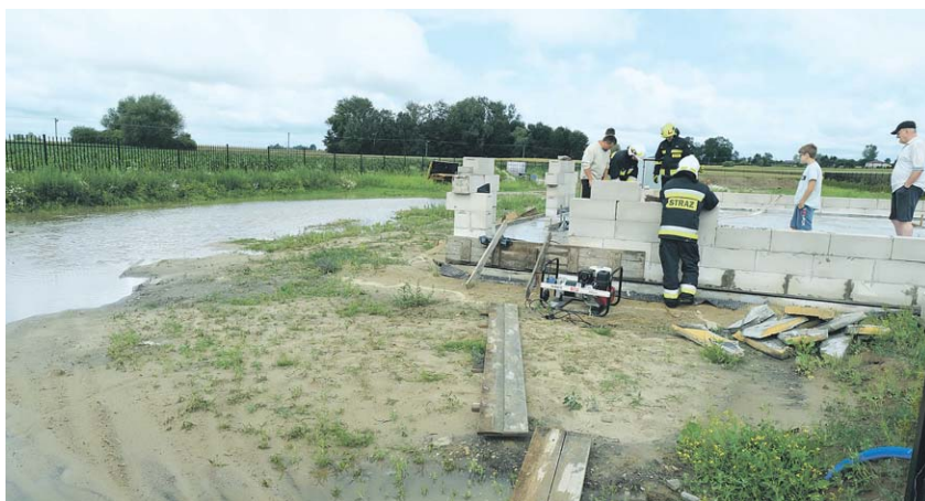
Druhowie z Ignacowa wypompowywali wczoraj wodę z posesji w Romanówce, na której trwa budowa
