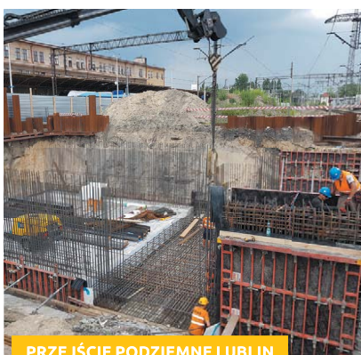
PRZEJŚCIE PODZIEMNE LUBLIN
