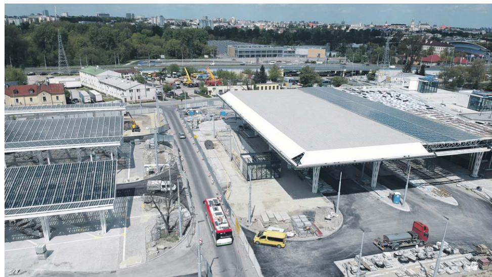
Rewolucyjne zmiany w kursowaniu komunikacji miejskiej są związane ze zbliżającym się oddaniem do użytku dworca autobusowego, który powstaje przy ul. Krochmalnej FOT. DW
