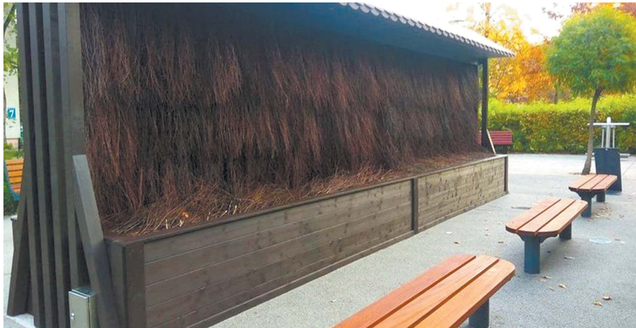
Tężnie solankowe w Puławach powstają ze środków z budżetu obywatelskiego już od kilku lat. Jedną z nich znajduje się przy ciągu pieszym prowadzącym od ul. Curie-Skłodowskiej do Skweru Solidarności. Kolejna, dzięki tegorocznemu głosowaniu, zostanie wybudowana na osiedlu Niwa
