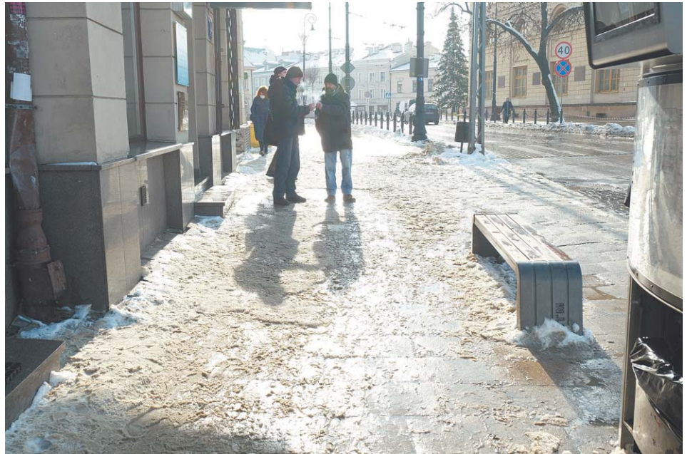
Będzie przetarg na projekt i wykonanie remontu chodnika w ul. Lubartowskiej pomiędzy ul. Bajkowskiego a al. Tysiąclecia
