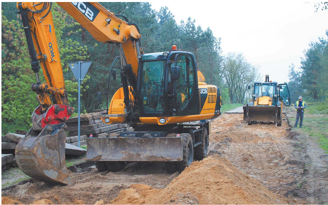
Budowa nowej ul. Powstańców Listopadowych w Puławach to przykład inwestycji, która otrzymała rządowe wsparcie z ramach FDS
