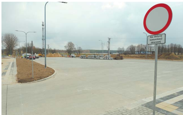
Przy ul. Żeglarskiej gotowa jest już betonowa pętla, parking, dobudowano też chodnik i drogę dla rowerów. Przebudowane jest też oświetlenie, powstał ponadto nowy odcinek kanalizacji burzowej
