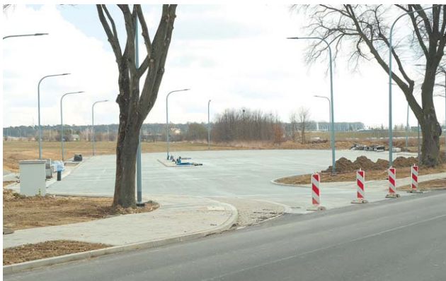
Przy ul. Franczaka „Lalka” trwa budowa chodników. Gotowa jest pętla, oświetlenie, odwodnienie. Wykonano też zatokę parkingową oraz odcinek chodnika i drogi rowerowej w stronę ul. Królowej Bony
