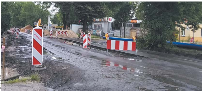
Prace na skrzyżowaniu ul. Kolejowej ze Starościńską
