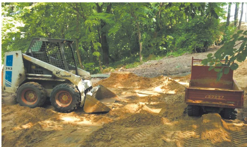
Na Podzamczu widać postępy robót przy budowie spacerowej promenady
