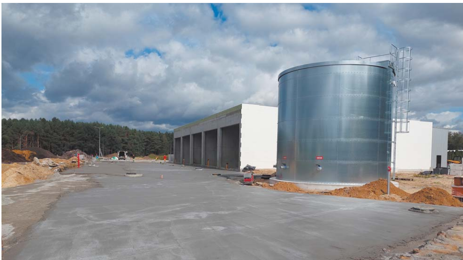
Fot. 3 Widok na bioreaktory i zbiornik p.poż. kompostowni osadów ściekowych
