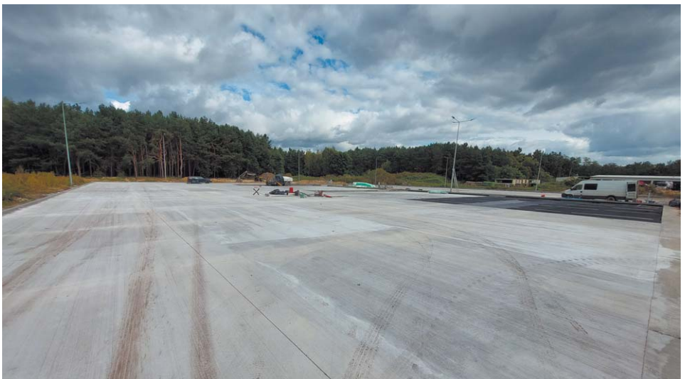
Fot. 4 Nawierzchnie betonowe placów kompostowni osadów ściekowych
