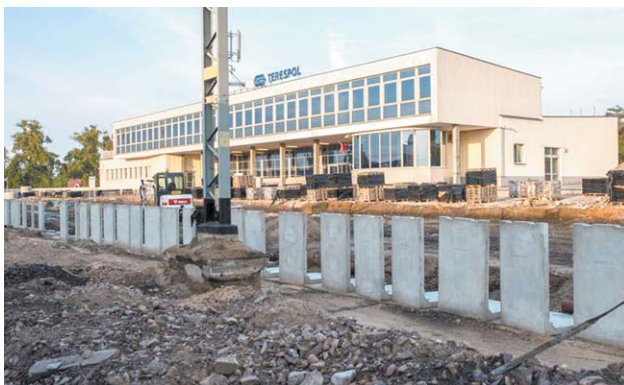
Na stacji w Terespolu kolejowa spółka zmodernizowała 12 torów i 20 rozjazdów
