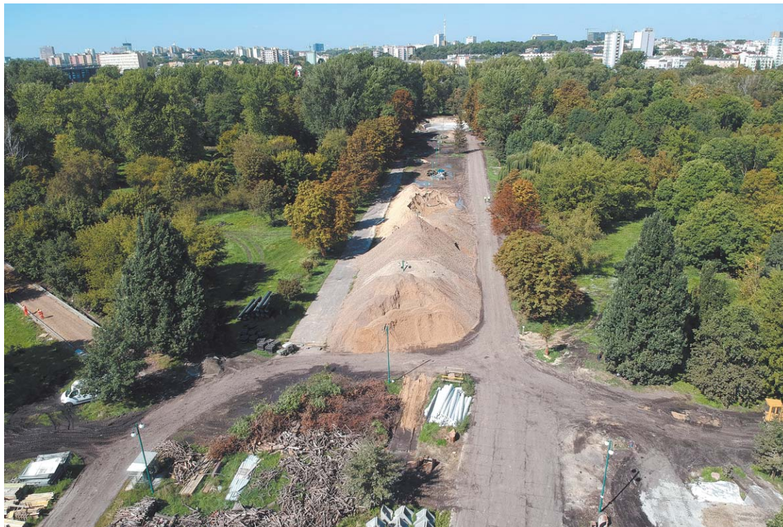
W odnawianym parku wyznaczono już przebieg nowych ścieżek, chociaż jeszcze nie wszystkie są w budowie
