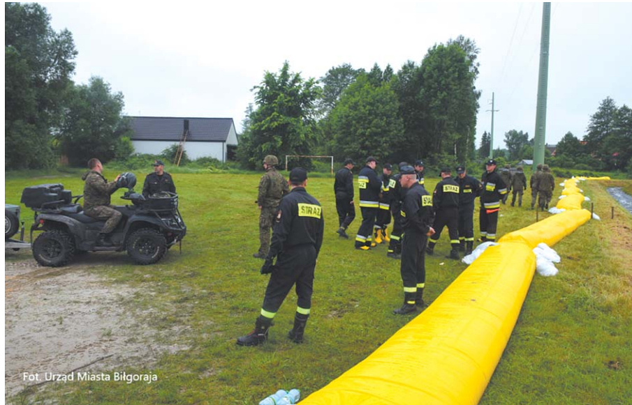
Zabezpieczanie zalewu Bojary rękawami przeciwpowodziowymi i workami z piachem
