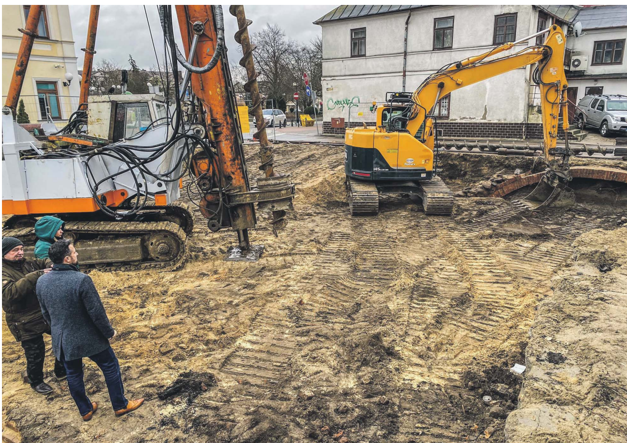
Podczas prac budowlanych przy kamienicy natrafiono na znaleziska, m.in. monety, kafle oraz łuk ceglany
