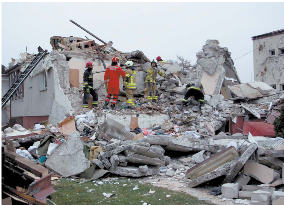
Siła uderzenia wyrywała okna razem z futrynami. Stan sąsiednich domów oceni nadzór budowlany
