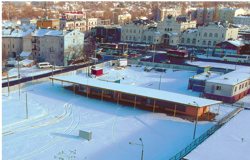
Teren budowy został już ogrodzony. Niedługo mają tu wjechać buldożery
