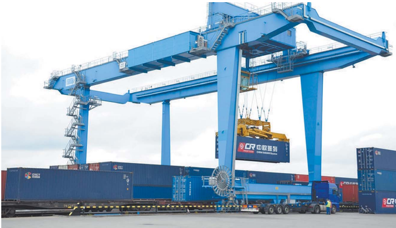
Kolej zapowiada budowę Parku Logistycznego. Inwestycja obejmuje przebudowanie dróg, dzięki czemu powstanie m.in. wiadukt nad torami i drogi dojazdowe do planowanej autostrady A2, która ma zostać doprowadzona do Terespoła
