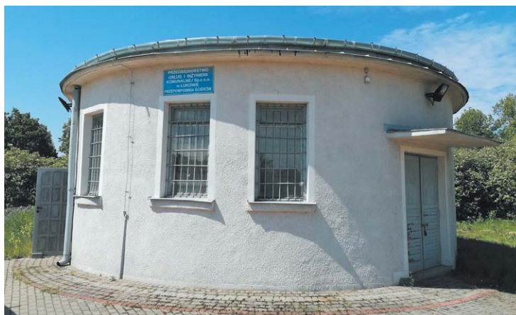
Przepompownia ścieków w Parku Miejskim w Łukowie
