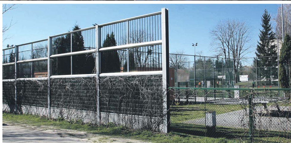
W marcu 2022 przy ul. Krahelskiej stanęła ściana długa na 63 metry, a wysoka na 4, która miała zadbać o akustyczny komfort sąsiadów Orlika
