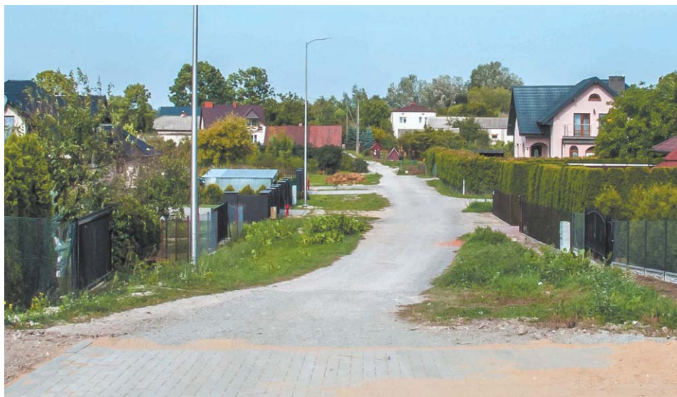
Droga zostanie wyłożona kostką brukową, będzie także oświetlona
