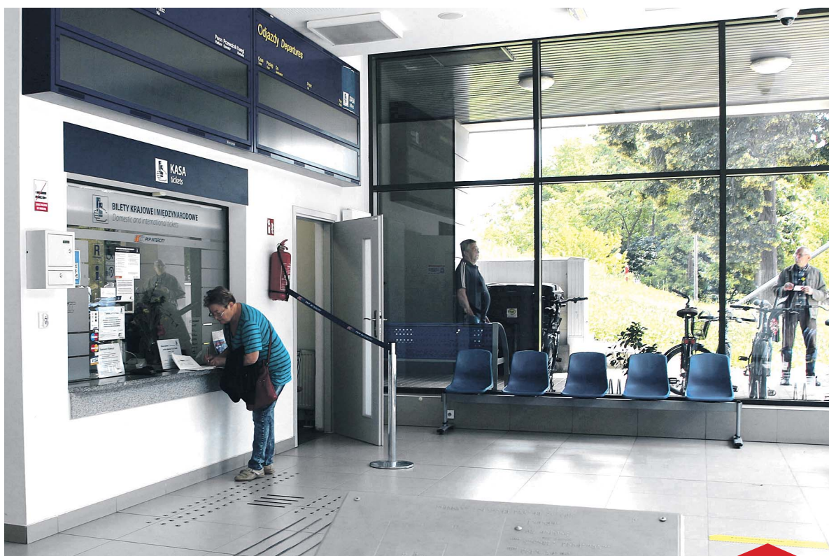
Główny remont budynku dworca kolejowego Puławy Miasto (za ok. 2,7 mln zł netto) zakończył się w 2016 roku. PKP chwaliło się wówczas, że „okienka kasowe dostosowano do potrzeb osób niepełnosprawnych” (obniżono błądy i wyposażono je w pętlę indukcyjną, która ułatwia komunikację osobom niedosłyszącym). Na ścianie nad kasą zawieszona duża, elektroniczna tablica z rozkładem jazdy. Dziś ta tablica nie działa
