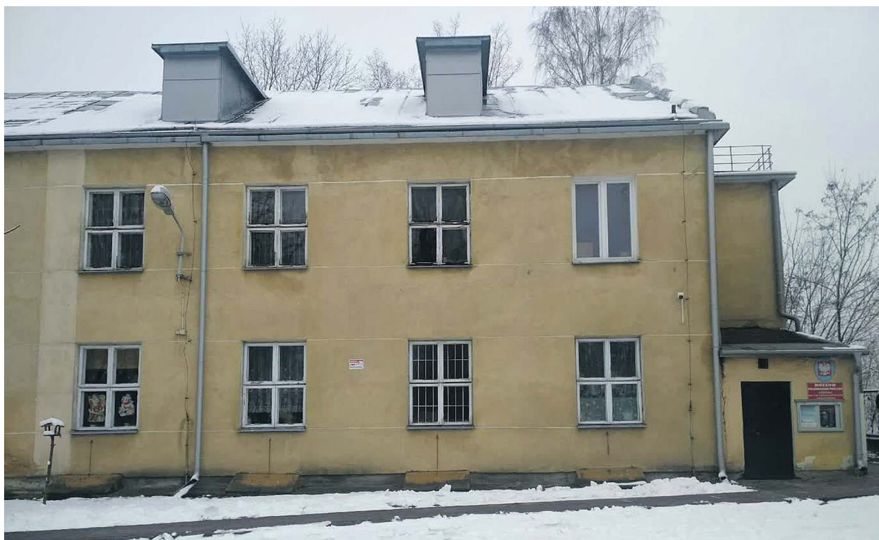
Stropy grożą zawaleniem, a część ekspozycyjna została niedawno zalana. Czy siedziba oddziału muzeum wreszcie doczeka się remontu?
