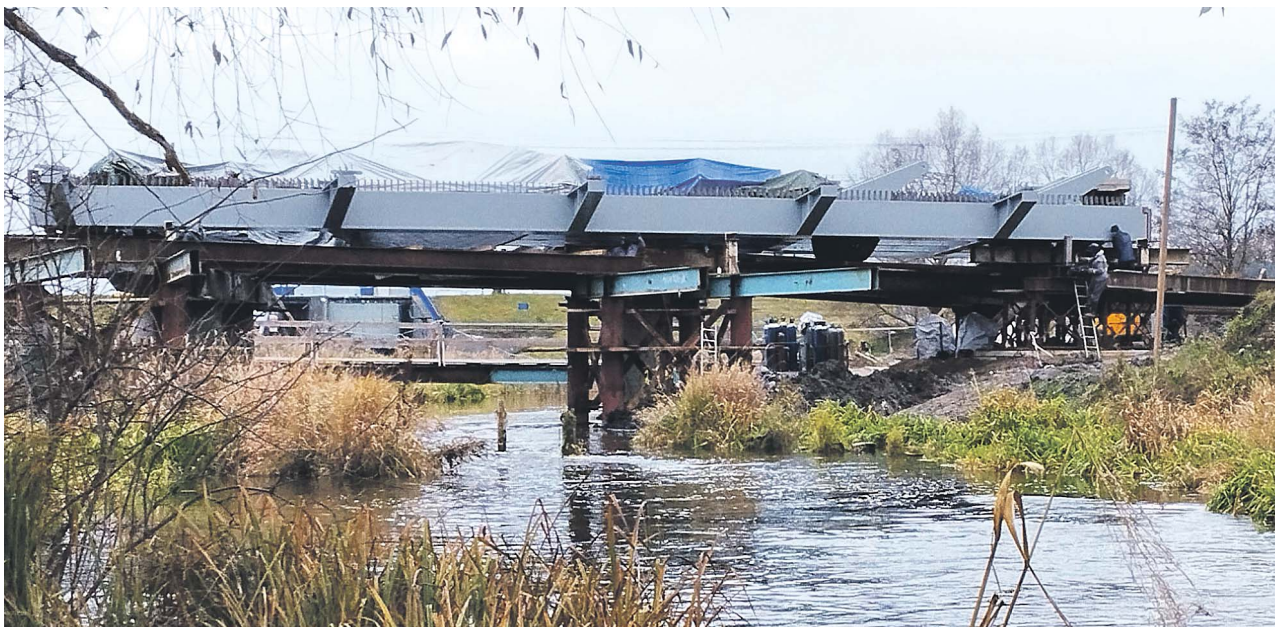
Na placu budowy nowego mostu spawana jest już część stalowej konstrukcji
