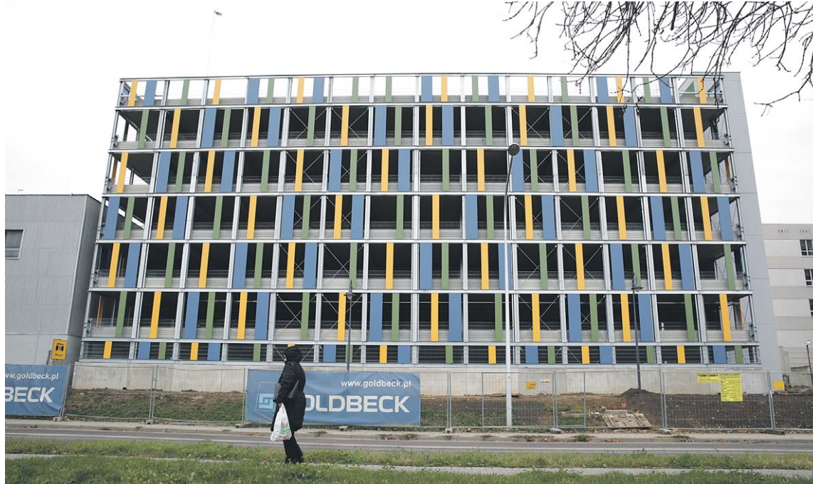
Budowa parkingu na 793 samochody mocno się przedłuża
