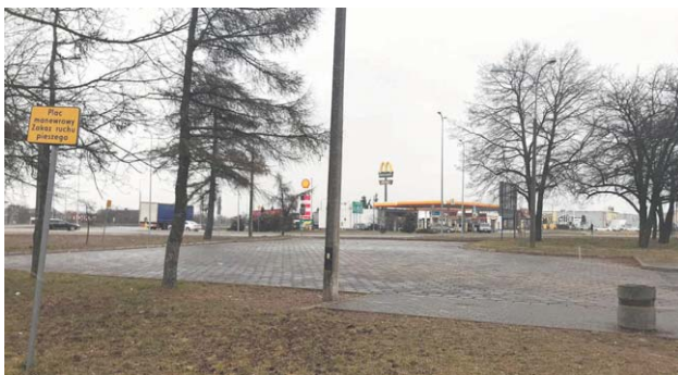
Na pętli przy ulicy Terebelskiej ma stanąć ładowarka do autobusów elektrycznych
