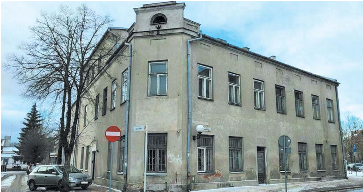
Kamienica przy ulicy Krótkiej 1
