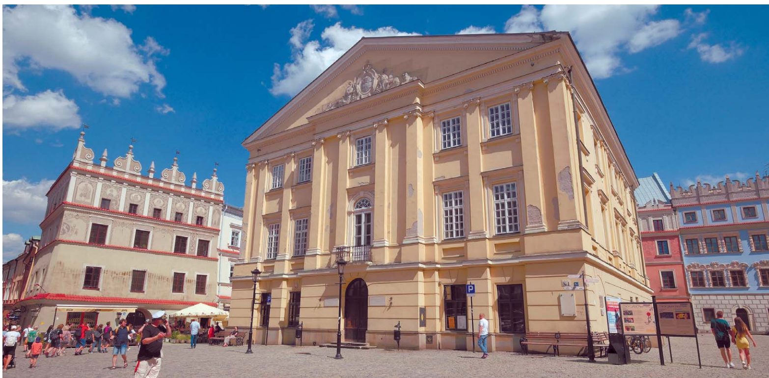
Miasto Lublin starało się m.in. o pieniądze na modernizację zabytkowego budynku dawnego Trybunału Koronnego. Aktualnie trwa przygotowywanie dokumentacji tej inwestycji. Ratusz liczy, że w razie zdobycia finansowania, prace uda się rozpocząć w przyszłym roku
