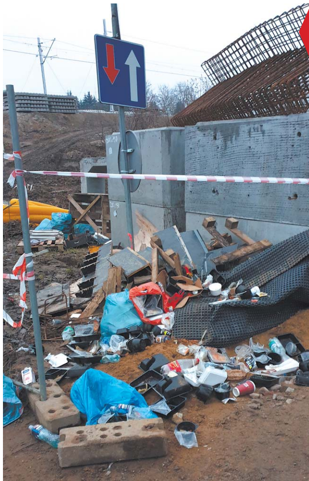
Mieszkańcy Czesławic narzekają na firmę wykonującą prace przy wiadukcie
