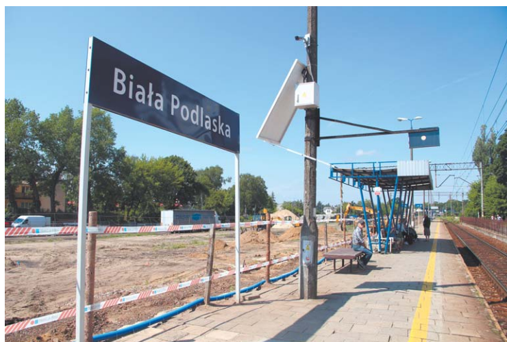
Prace trwają m.in. na stacji w Białej Podlaskiej
