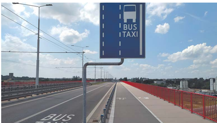
Na ul. Grygowej natknęliśmy się na stare znaki już po tym jak Ratusz ogłosił, że zakończono prace przy nowym oznakowaniu buspasów
